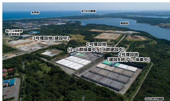
図1 六ヶ所低レベル放射性廃棄物埋設センター
