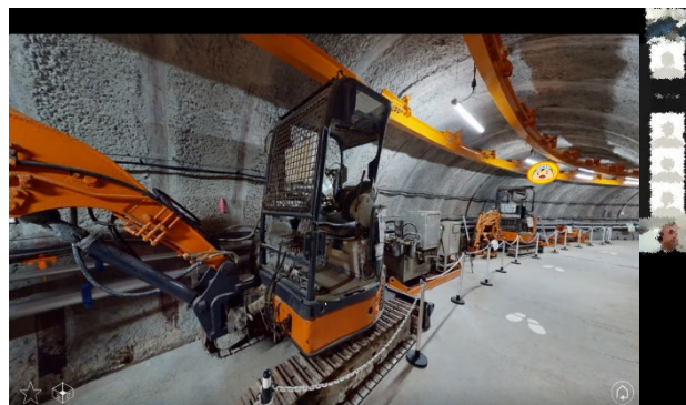
写真 1 オンライン見学状況 (350 m 坑道)
