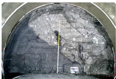
Fig.4 境界面が完全に癒着している断層[1]
