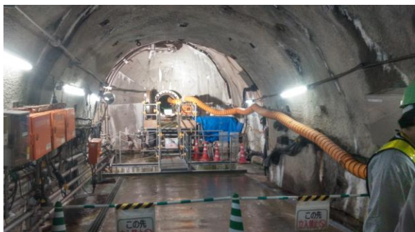
写真1 再冠水試験の止水壁（深度500m地下坑道）
