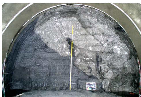
図4 境界面が完全に癒着している断層[1]
