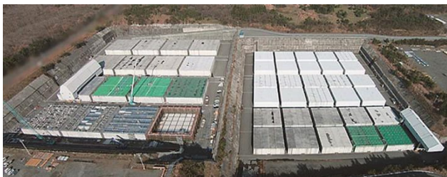
図1 廃棄物埋設地の全景(2014年11月)
