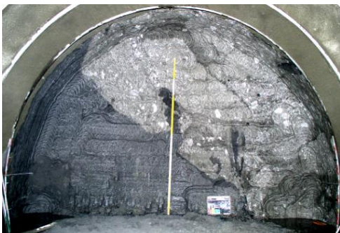
図4 境界面が完全に癒着している断層[1]
