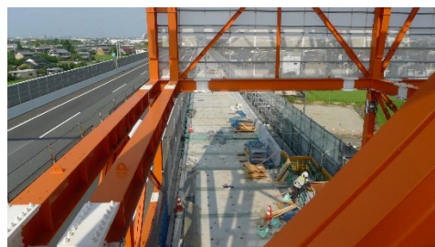
写真4 蟹江IC付近床版取換工事見学
