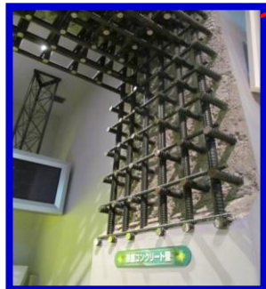
鉄筋コンクリート壁の実規模大模型 (日本原燃・六ヶ所PR館)
