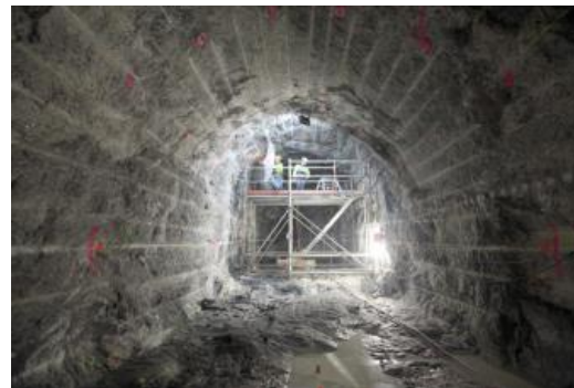
オルキルオト地下特性調査施設
