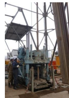
掘削作業の様子
