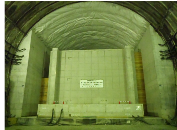
模擬試験施設の全景
