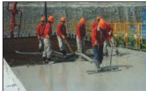
覆い(鉄筋コンクリート)を打設
