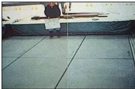
上部ポーラスコンクリート設置
