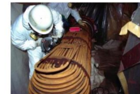
熱交換器チューブの解体
