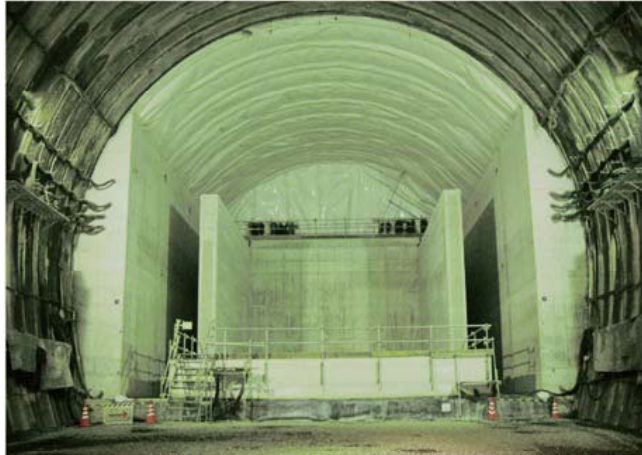
地下空洞型処分施設の施工確認試験施設(平成20年度)
