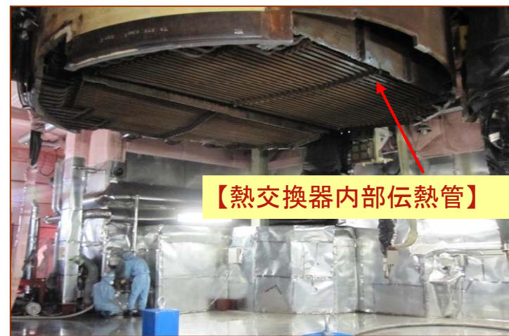
熱交換器ティア切断状況
