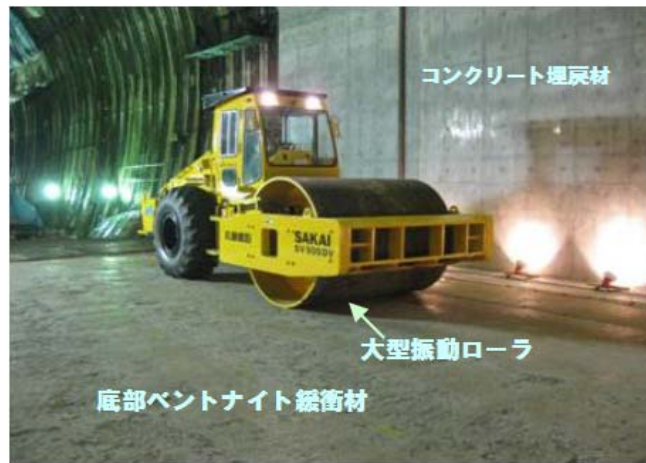
大型振動ローラを用いた底部ベントナイト緩衝材 施工確認試験(平成20年度)
