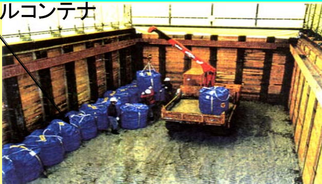
埋設施設での廃棄物の定置作業
