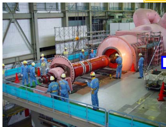
発電機撤去【撮影日:平成15年5月頃】
