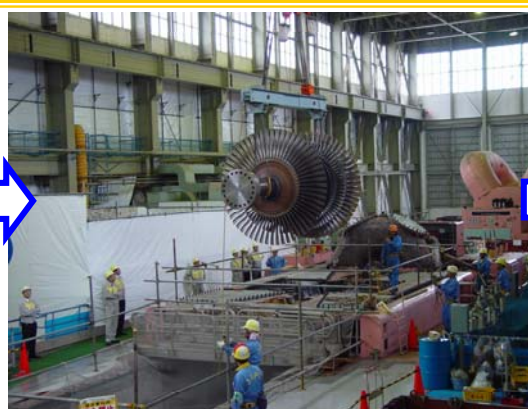
低圧タービン撤去【撮影日:平成15年6月頃】
