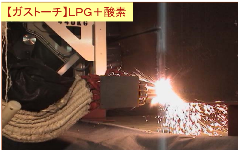
熱交換器胴部の熱的切断作業
