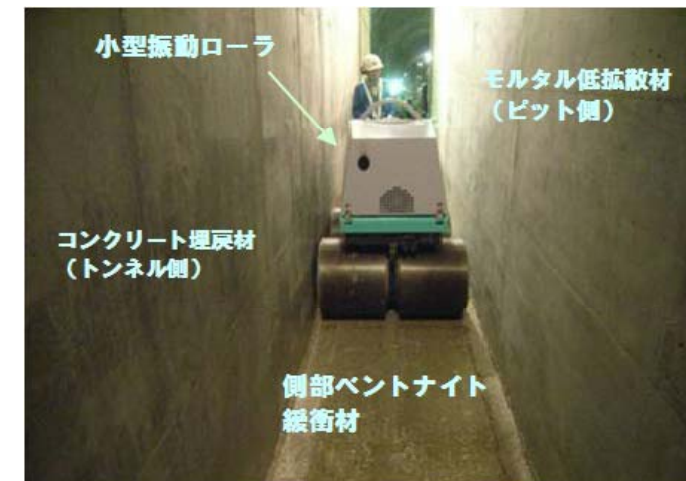
小型振動ローラを用いた側部ベントナイト緩衝材 施工確認試験(平成22年度)
