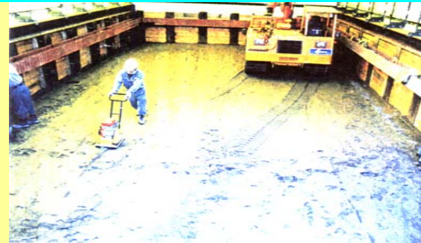
廃棄物上部への覆土、土砂の締め固め作業
