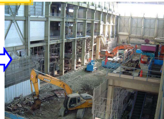
建屋内機器撤去【撮影日:平成16年1月頃】
