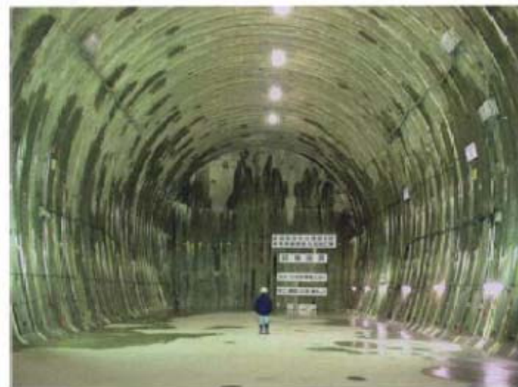
試験空洞(幅18 m, 高さ16 m) JNFL Webより
