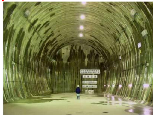
試験空洞構築状況
