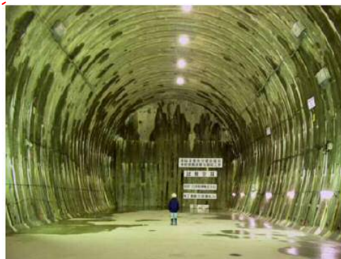
試験空洞構築状況
