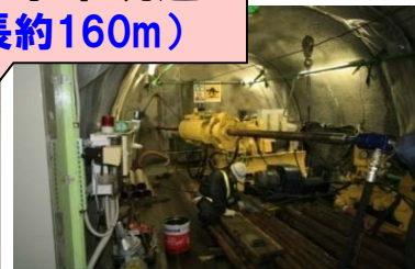
水質観測ボーリング孔の掘削 (瑞浪300m水平坑道)
