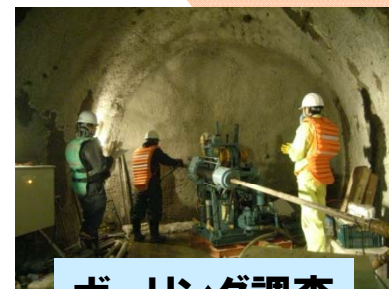
ボーリング調査
