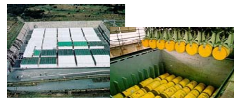
日本原燃(株) 低レベル放射性 廃棄物埋設センター (青森県六ヶ所村)
