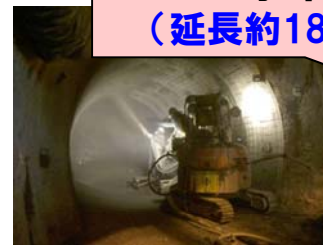
低アルカリ性セメントを用いた コンクリートによる吹付け施工 (幌延140m水平坑道)
