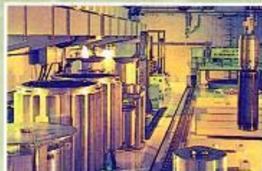
遠隔操作によるガラス固化体検査
