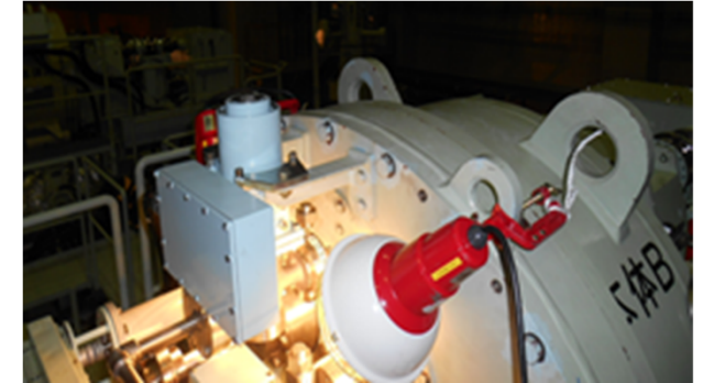
本体Bの照明による加温状況
