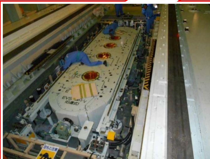
床ドアバルブ（6連式）取外し作業状況
