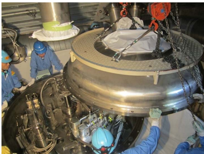
缶詰装置容器開放作業状況
