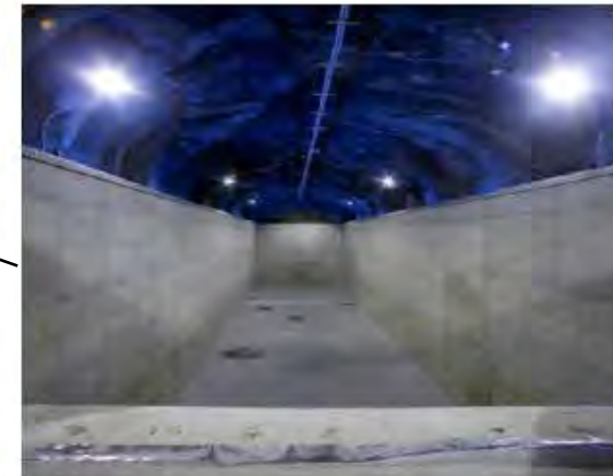
中レベル処分空洞 (固型化処理された廃棄物の処分)
