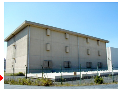
保管廃棄施設
