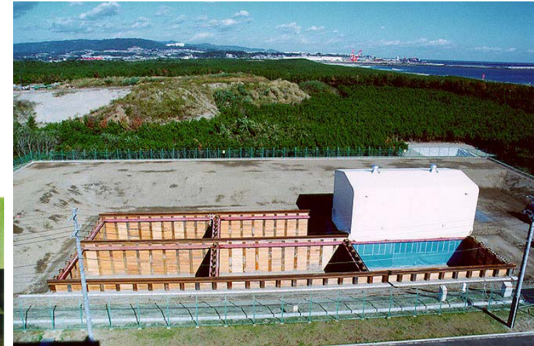
写真3 廃棄物埋設用トレンチ外観及び雨水浸入防止用テント(定置開始前)
