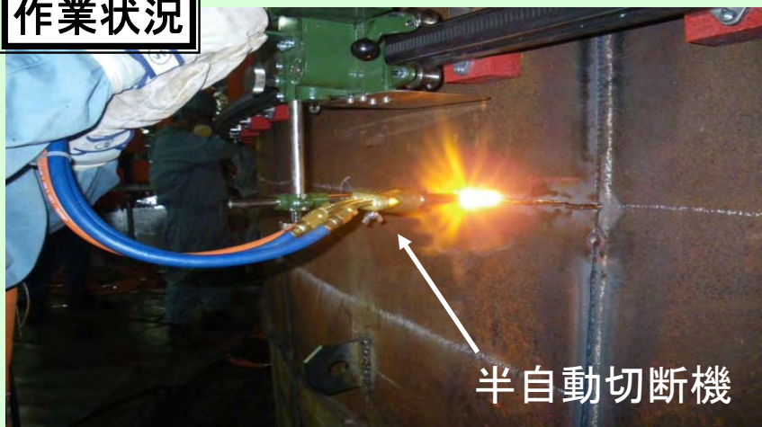
半自動切断による切断
