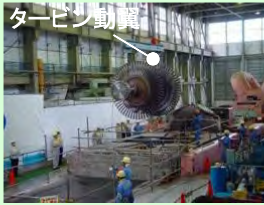
低圧タービン撤去 【撮影日:2003年6月頃】
