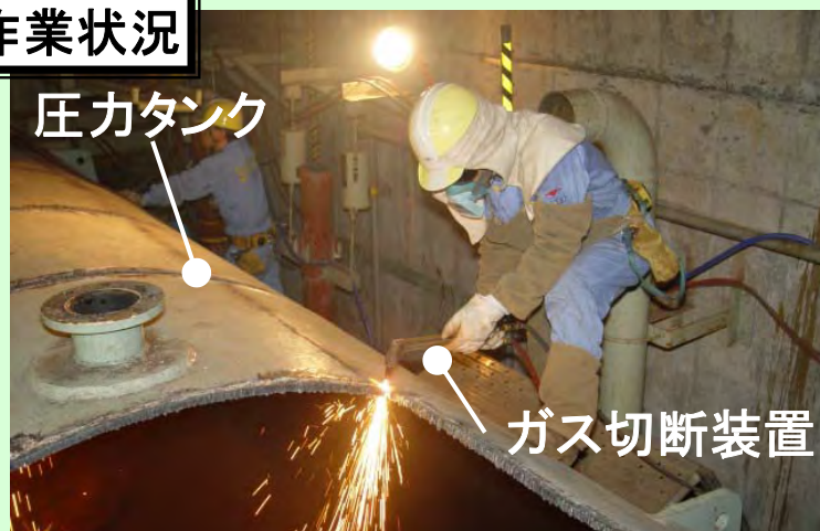
消火用圧力タンク撤去 【撮影日：2004年8月頃】
