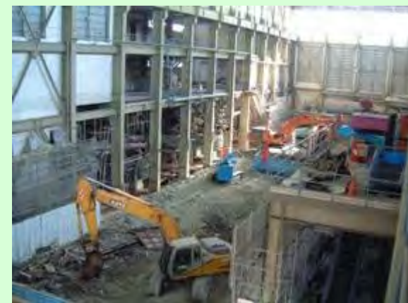
タービン建屋内機器撤去 【撮影日:2004年1月頃】
