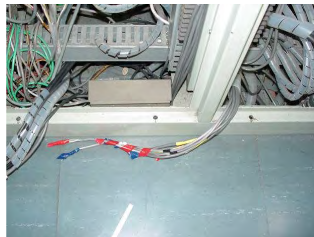
制御盤裏コネクタ開放状態の様子
