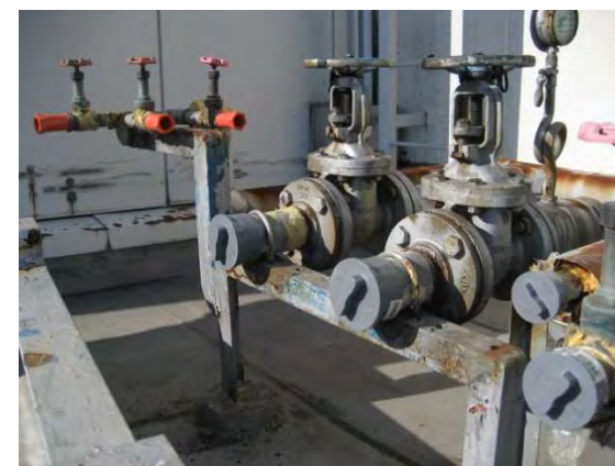
配管部の閉止状況
