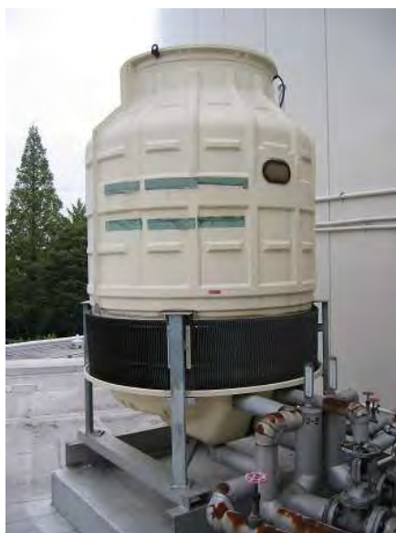
クーリングタワーの撤去前の状況 （屋外）
