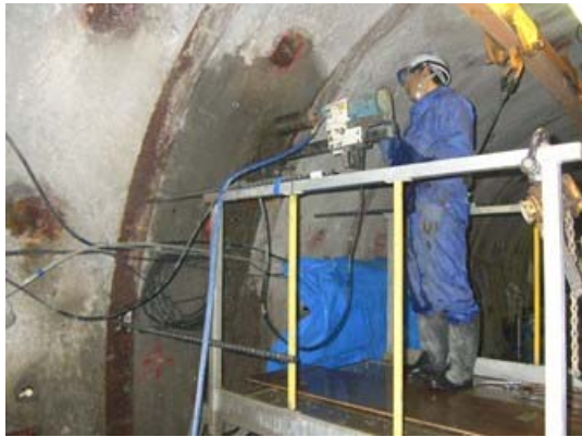
ボーリング掘削
