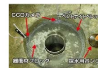
写真4 試験坑設置完了
