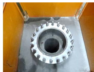
コンクリート支保
