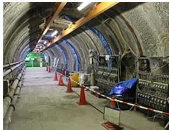
深度350m西連絡坑道 (平成27年7月2日撮影)
