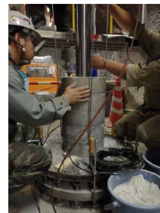
緩衝材・計測器設置状況
