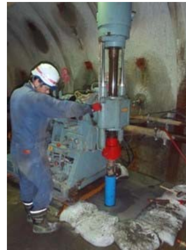
ボーリング削孔
