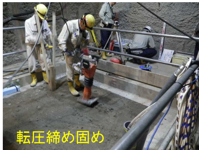
坑道の埋め戻し
