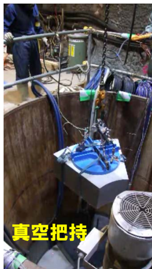
緩衝材の設置
