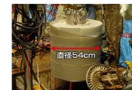
写真2 緩衝材ブロックの設置状況
