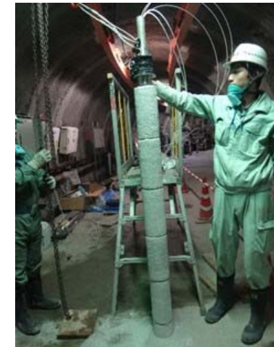
緩衝材設置状況
