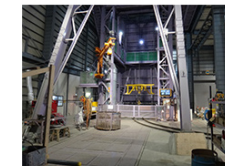
写真 ② 西立坑坑口 (平成27年1月28日 11時頃) 【写真の解説】 西立坑坑口の状況です。
