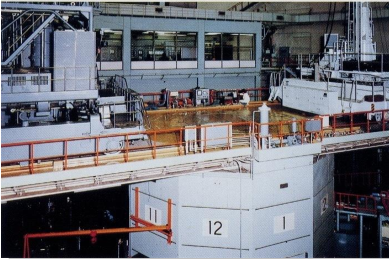
▲旧JRR-3炉室全景 (1983年3月)
