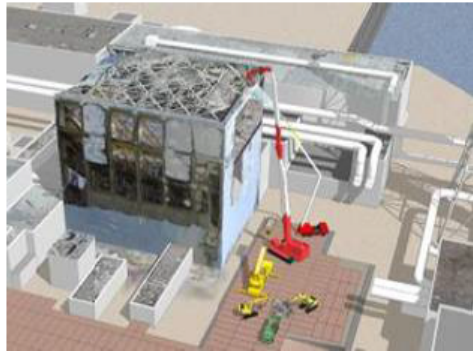
原子炉建屋上部のガレキ撤去
