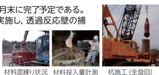
材料混練り状況 材料投入量計測 杭施工(全旋回)
