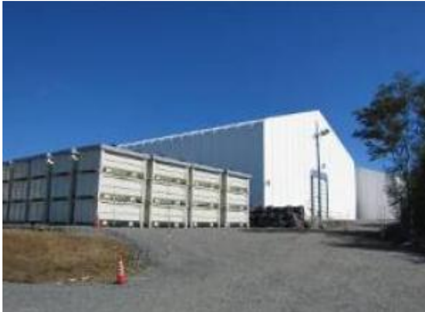
瓦礫保管コンテナと建屋上部ガレキ保管テント
