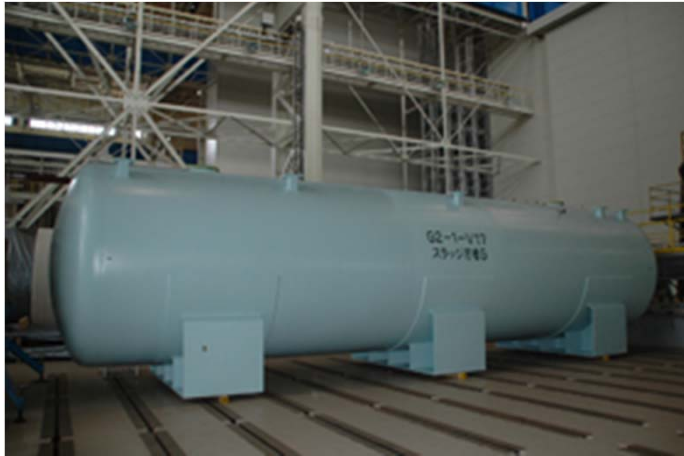
廃スラッジ一時保管施設貯槽
