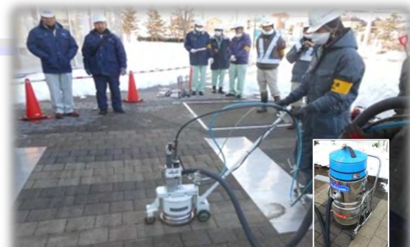
フロアクリーナによる除染状況
