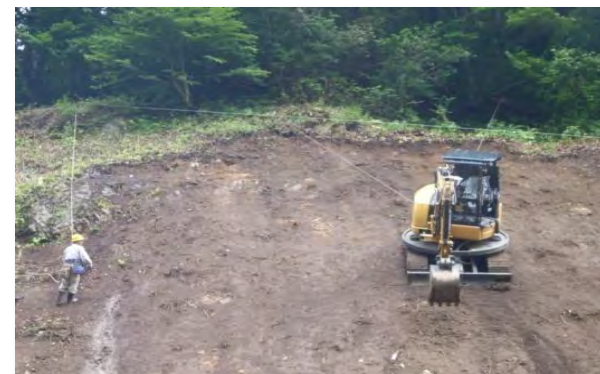
無人高所掘削機械表土剥ぎ取り状況
