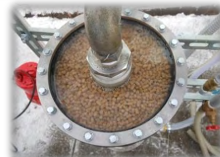
ゼオライトインラインフィルター(内部) 約15kg充填、φ20mm、長さ500mm
