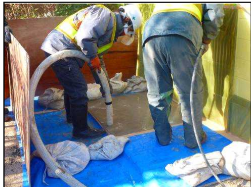
舗装面の高圧水洗浄
