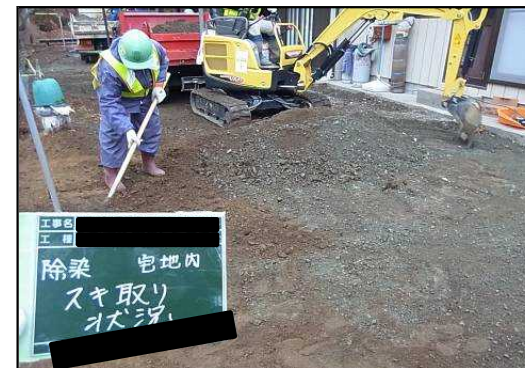
庭碎石の除去・被覆
