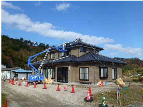
屋根・壁の拭き取り
