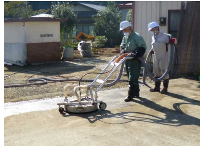
回収型高圧水洗浄
