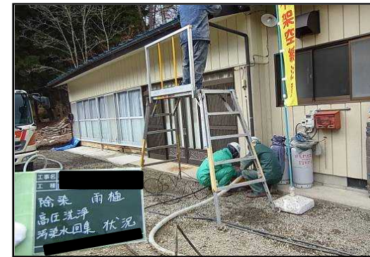
縦樋の高圧水洗浄
