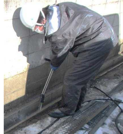
側溝の高圧水洗浄の例
