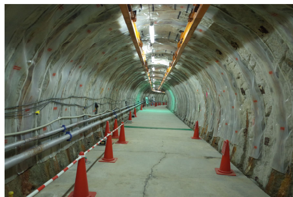
2016年10月24日、著者撮影 Fig.6 Photo of access tunnel of Horonobe Underground research center, JAEA
