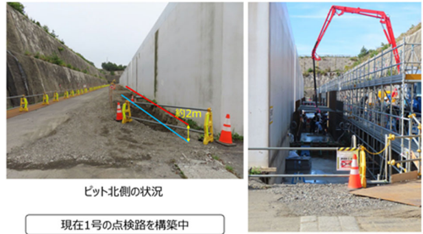
図7 点検路構築の様子
