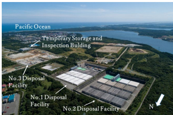
Fig.1 Rokkasho LLW Disposal Center
