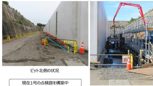
図7 点検路構築の様子
